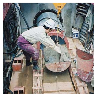
坑内ズリ出し状況
