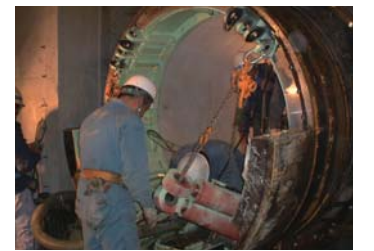
掘進機分割回収状況
