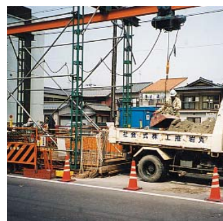
立坑上の門型クレーン・ダンプトラック
